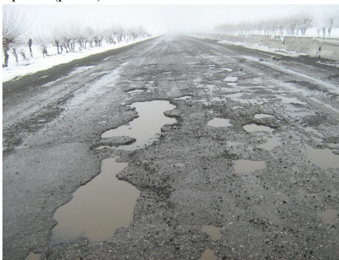
Рис.3. Виды разрушения автомобильных дорог от воздействия транспортных нагрузок и погодно-климатических факторов
